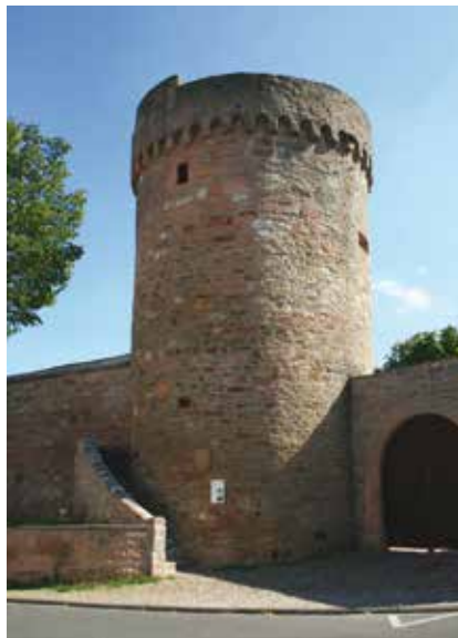
Stumpfer Turm in Großostheim – ehemaliger Pulverturm
